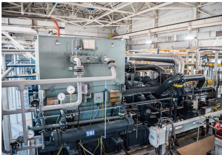
🕒 Дожимная компрессорная установка
