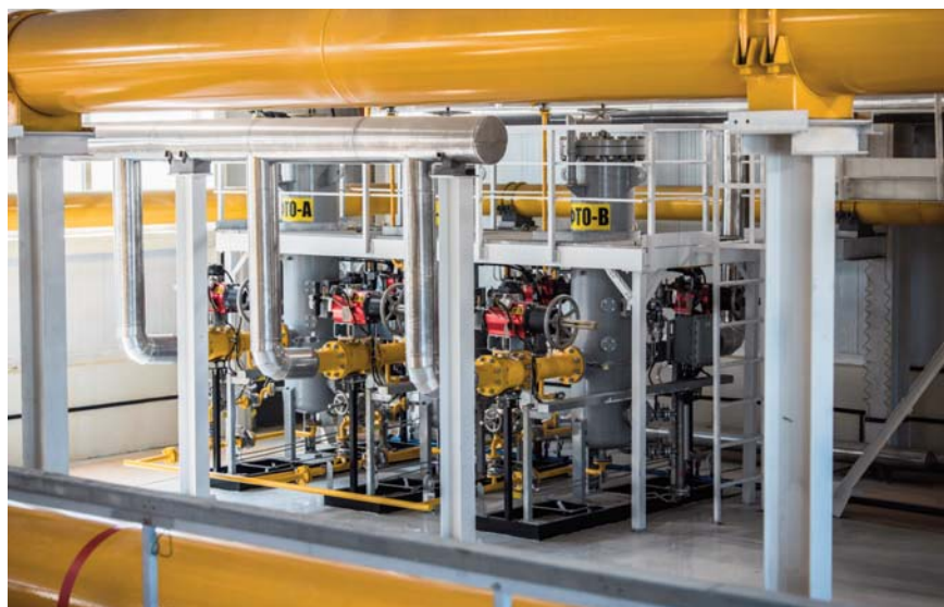
🕒 Фильтры тонкой очистки газа
